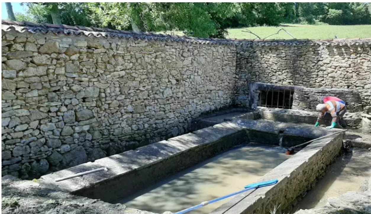
Un chantier engagé par les Amis du Patrimoine d'Arnaud-Guilhem : le lavoir de la Mesplère,
