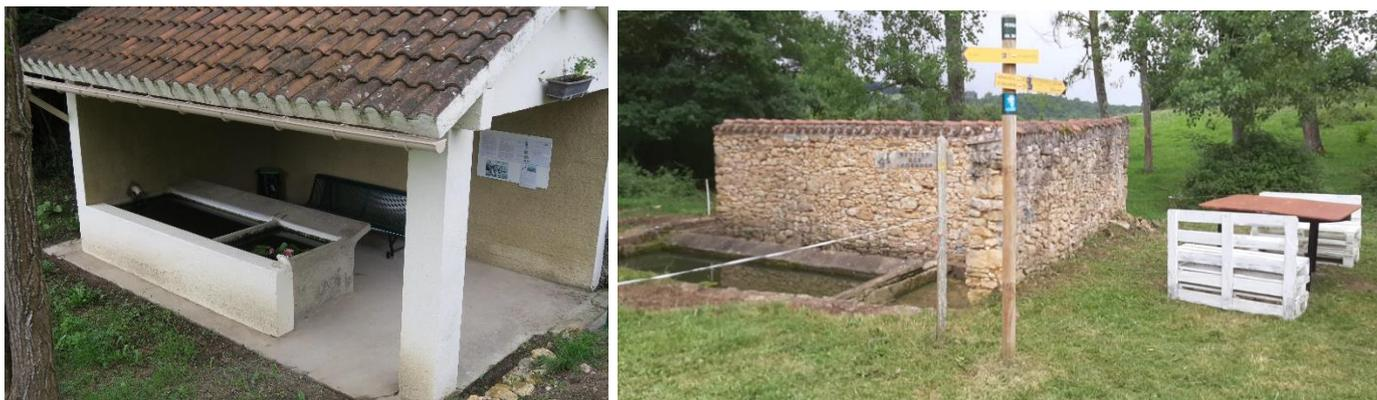
Le lavoir du Fond de la Côte a été restauré : pose de gouttières des deux côtés de la toiture, mise en place d'un système de récupération de l'eau de pluie pour l'amener dans les bacs, peinture sur l'ensemble du bâtiment.
